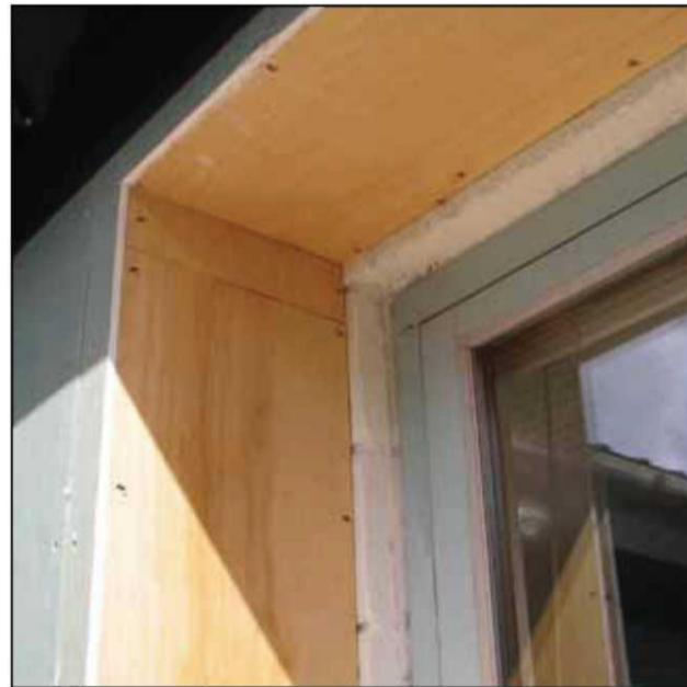
Słupek ISOVER Plus 2 przy oknie obudowany sklejką.
