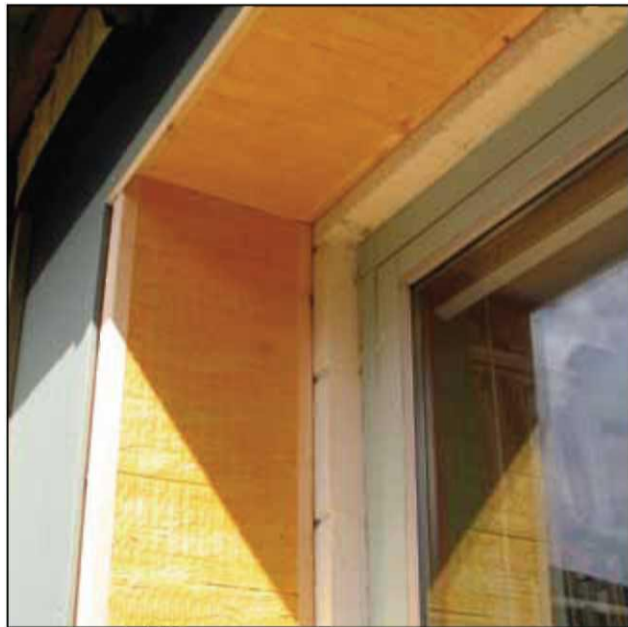
Słupek ISOVER Plus 2 przy oknie.
